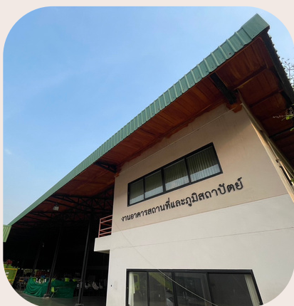
อาคารโรงซ่อมครุภัณฑ์
